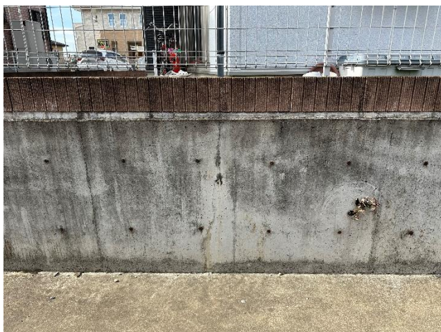
現場打ち擁壁
