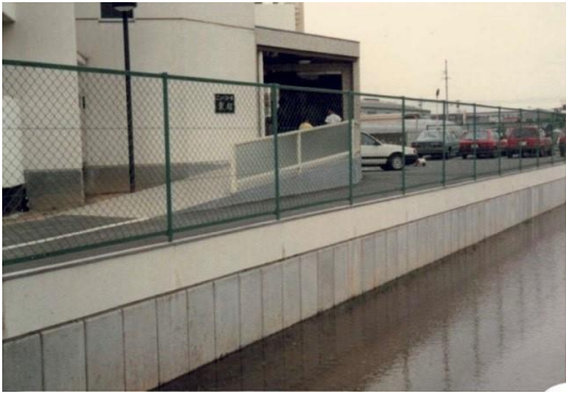
軟弱地盤施工
