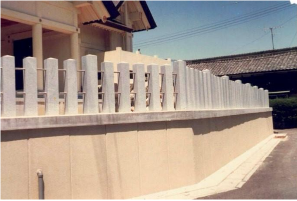
神社施工工事
