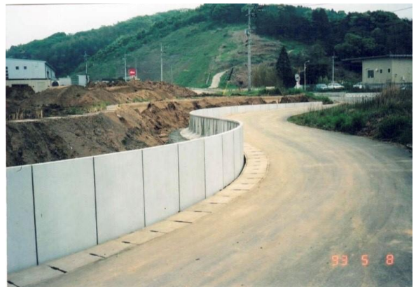
湾曲施工②
