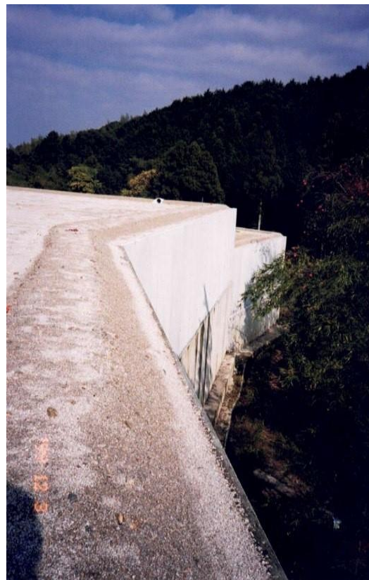
山間部傾斜地施工
