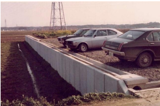
軟弱地盤施工
