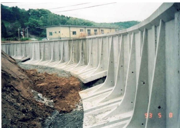
湾曲施工③
