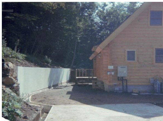
山間部土留め施工
