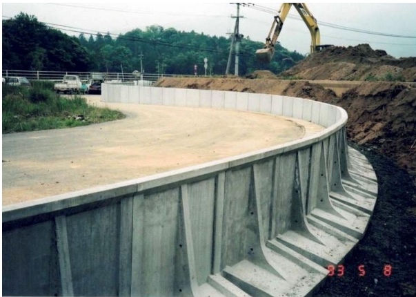
湾曲施工①
