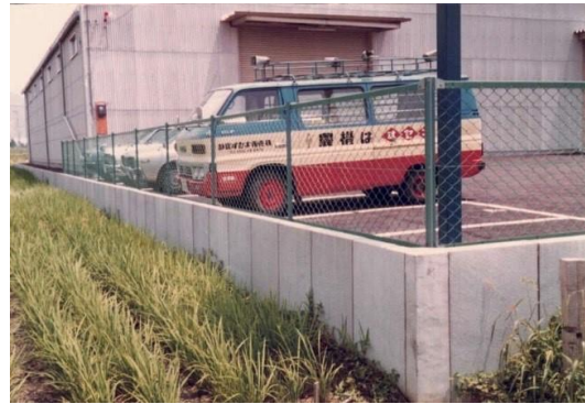
軟弱地盤施工
