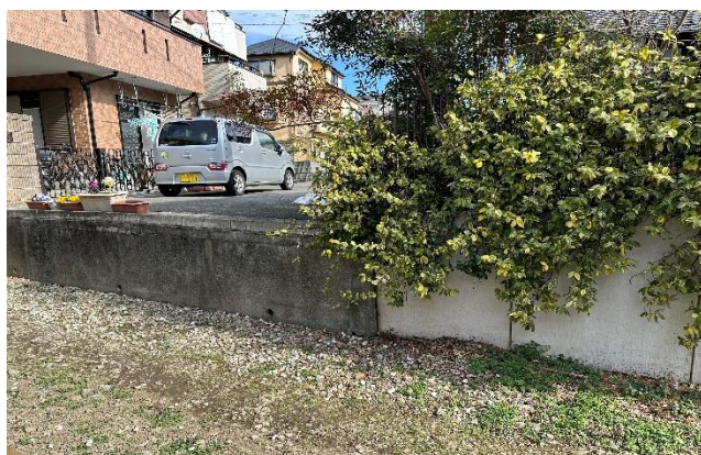
左側が現場打ち、右側が「L-105」
