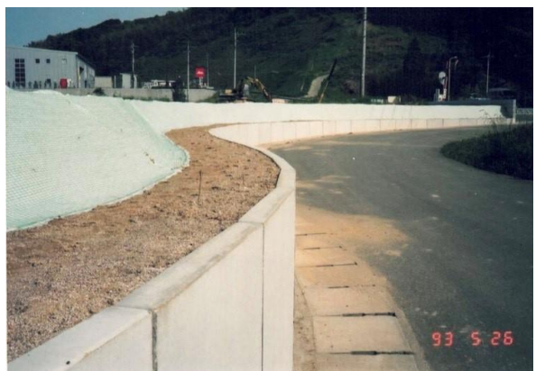
湾曲施工④
